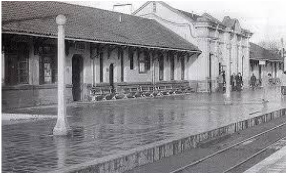
Ilustración 10: Fachada antigua de la Estación de Ovalle
